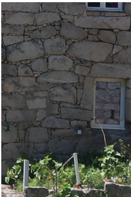
Maçonnerie de pierre à joints vifs en opus incertum
