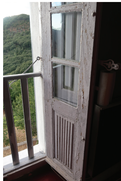
Fenêtre à double battants et volets intérieurs (début XXe S)
