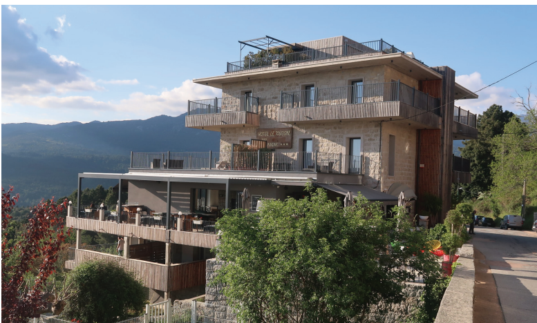
2022 (travaux réalisés en 2019)
