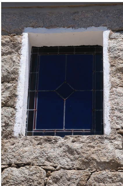
Fenêtre à chassis fixe en vitrail (XIXe S)
