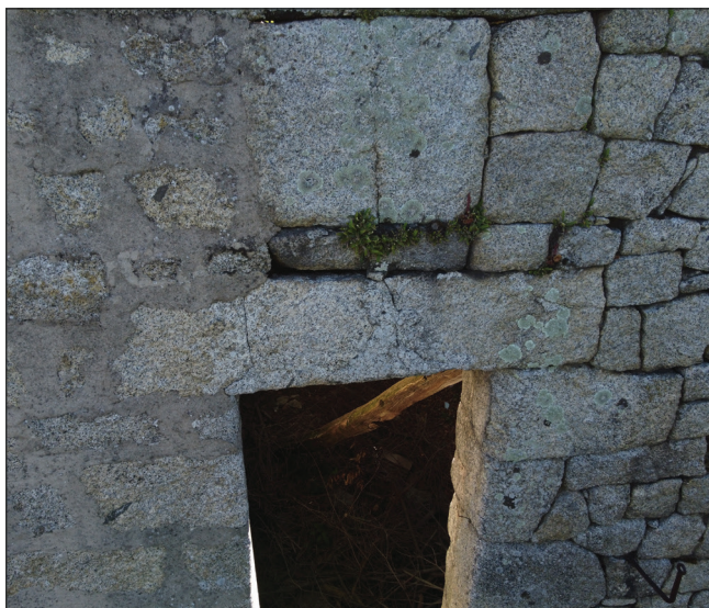
pierre d'évier en façade ouest
