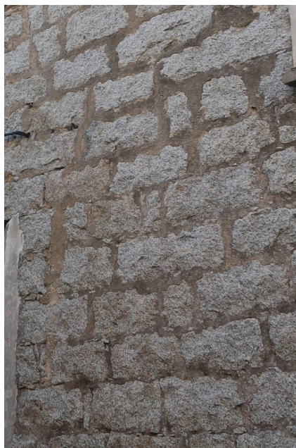
Maçonnerie de pierre à joints au mortier de chaux
