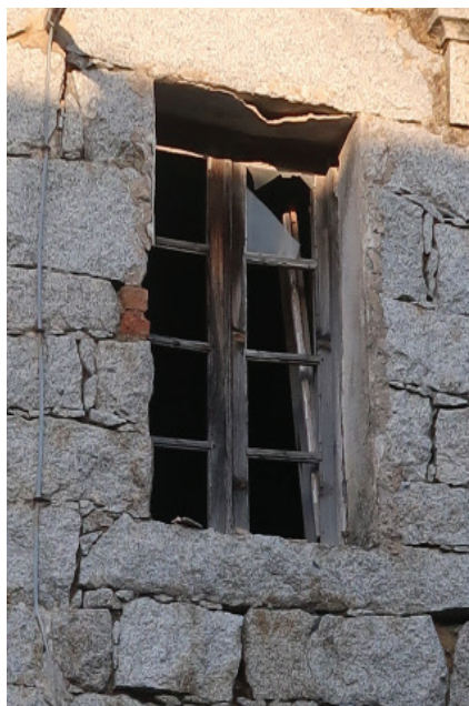
Menuiserie de fenêtre double battants à petits bois et grands carreaux (XIXe S)
