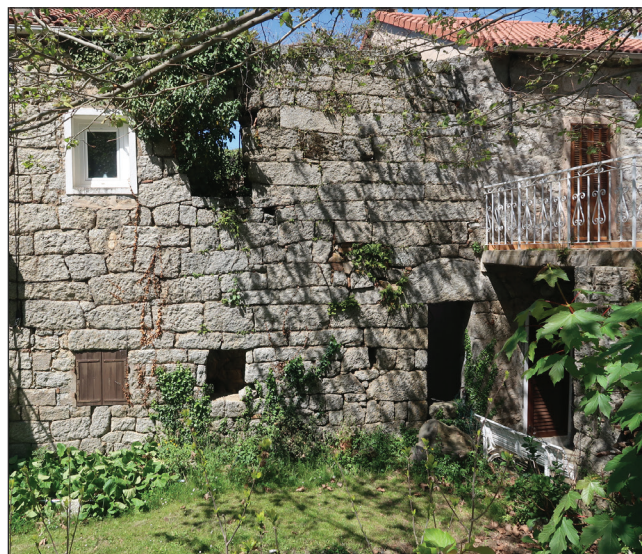
façade est, entrée de plein pied au rez-de-chaussée surrélevé; linteau en boule
