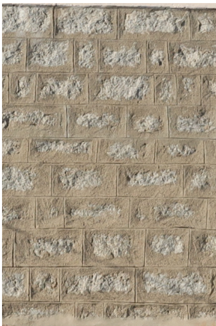
Enduit à pierre vue avec faux joints tirés au fer
