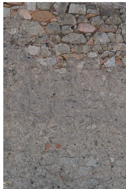
Enduit couvrant au mortier de chaux et sable
