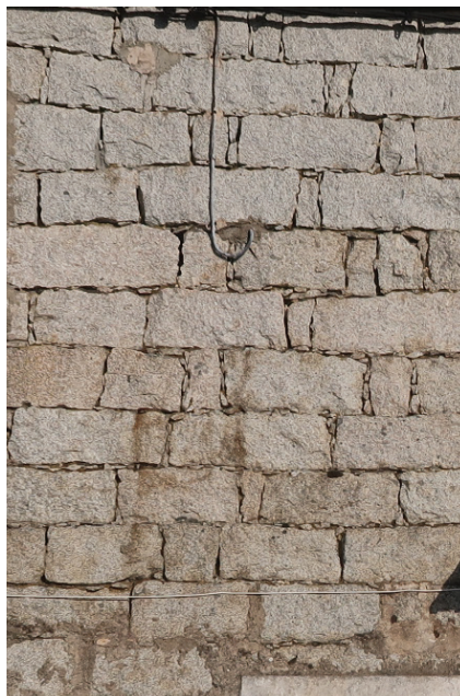
Maçonnerie de pierre assisées calées à joints vifs
