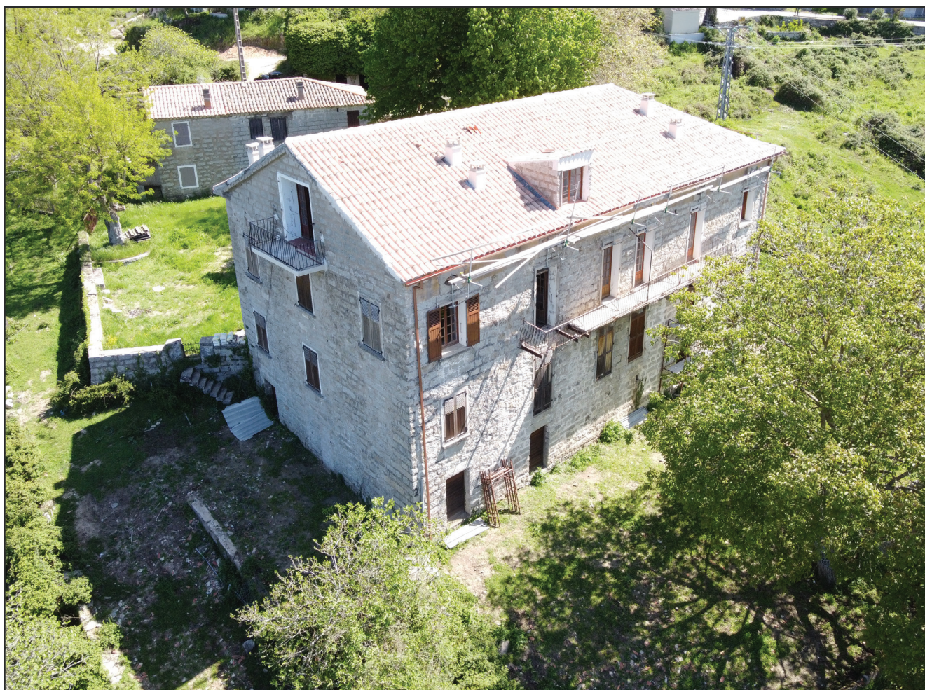
façades sud et est en cours de travaux
