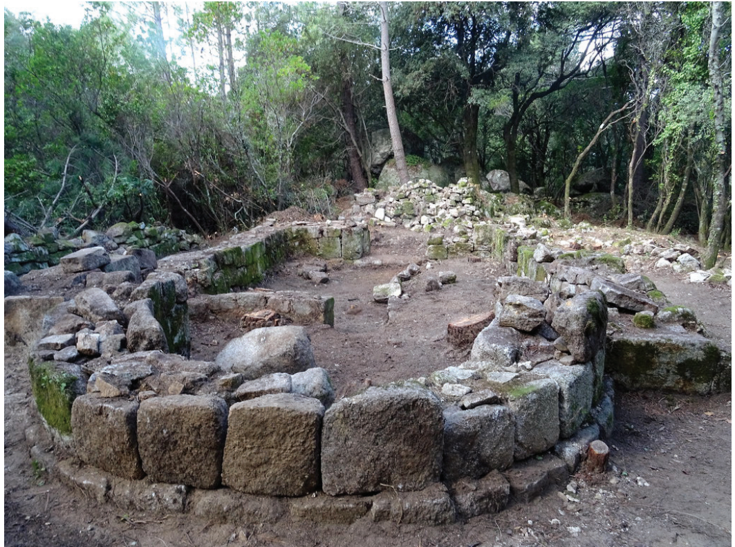
23. CHAPELLE SAN MARTINU DE ZONZA RUINES DE LA CHAPELLE EN 2021. ( http://apuntabunifazinca.com )
